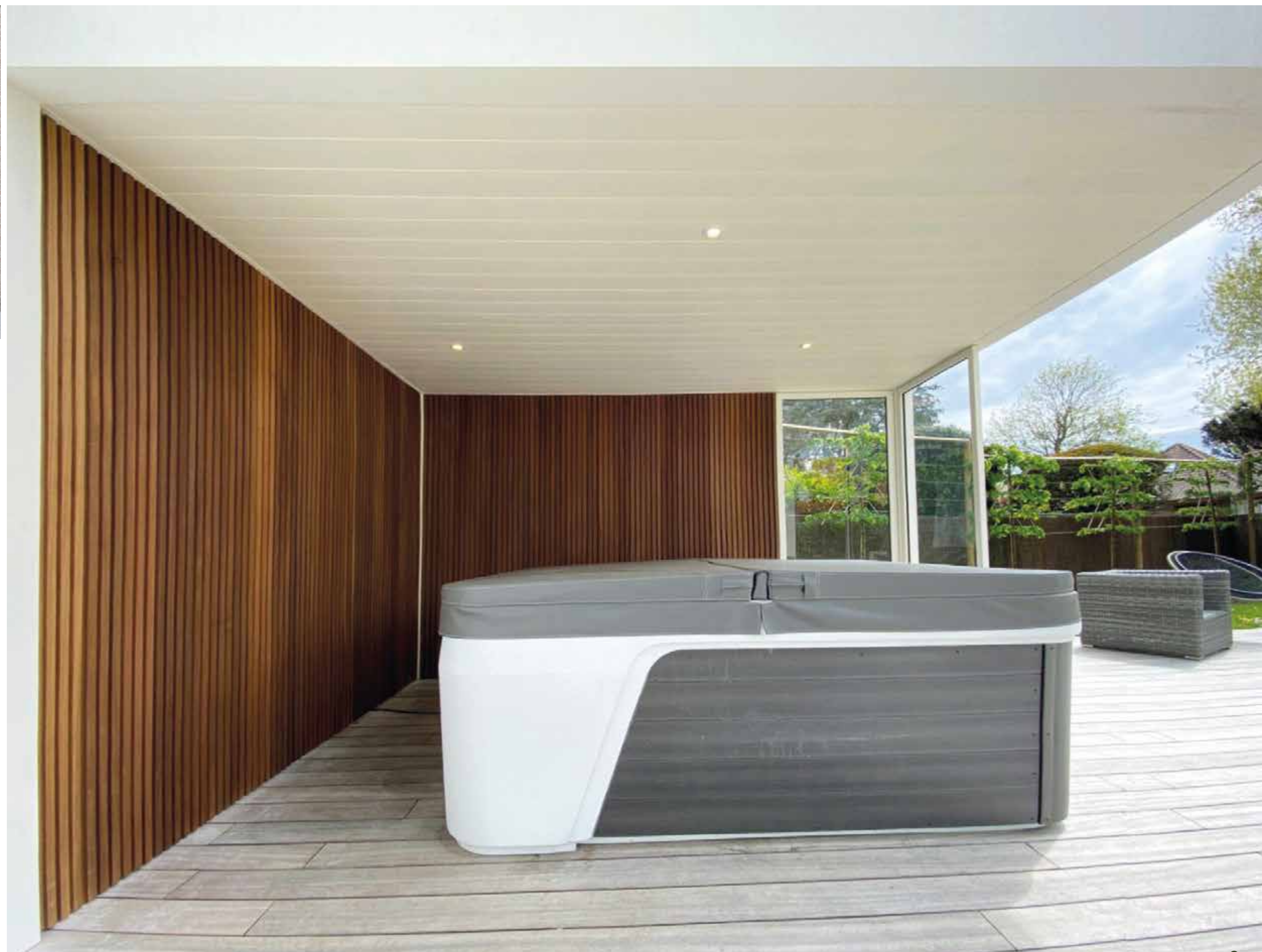
Maluwi en RAL 9010 en thermowood ayous et une sous-toiture en aluminium RAL 9010
